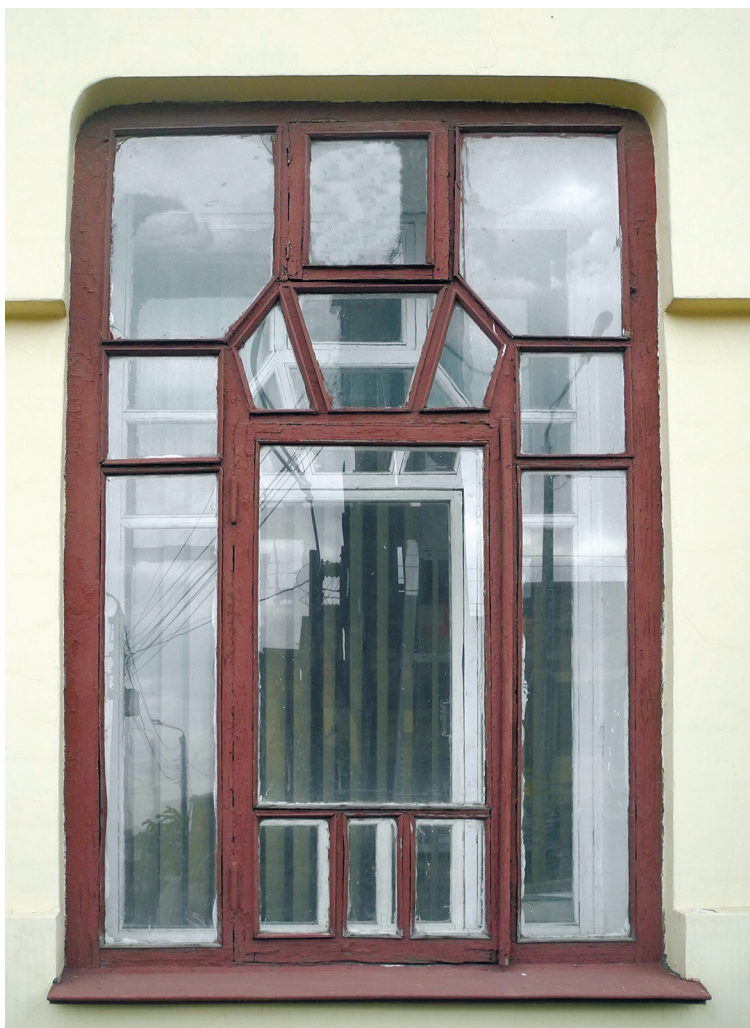
Обформление оконного проема
