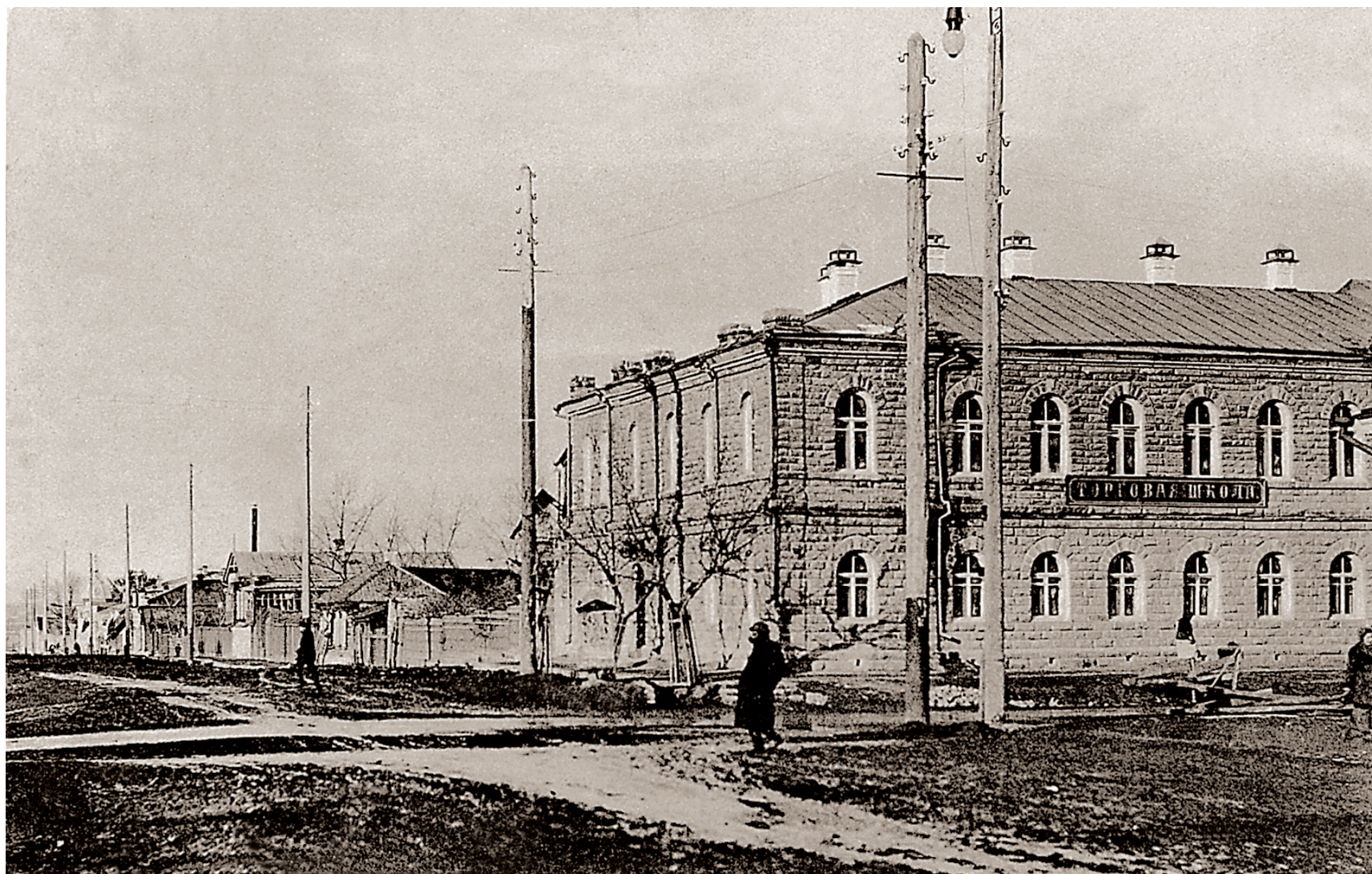
Особняк отставного поручика Апполона Апполоновича Жемчужникова. С 1900 года дом стал собственностью потомственного почетного гражданина М. И. Морозова. В 1913 году в здание переехала челябинская торговая школа.
