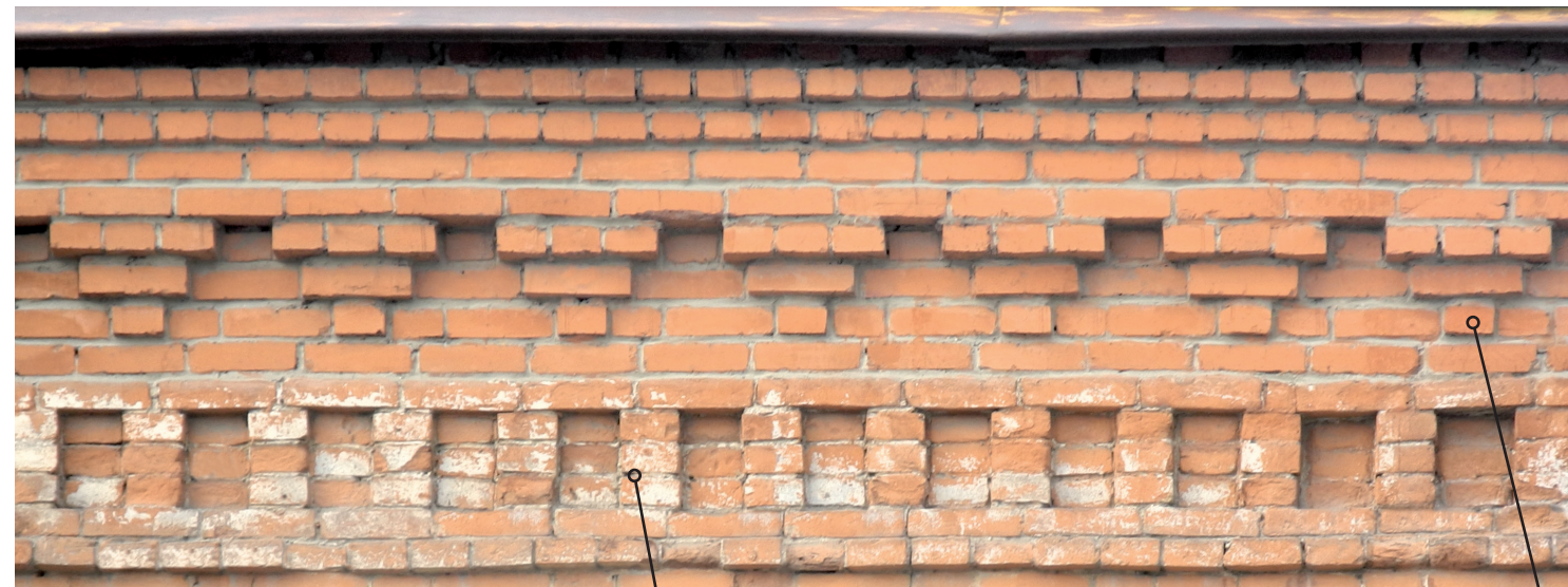
фрагмент южного фасада
