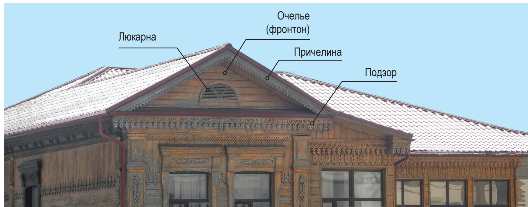
фрагмент северного фасада
