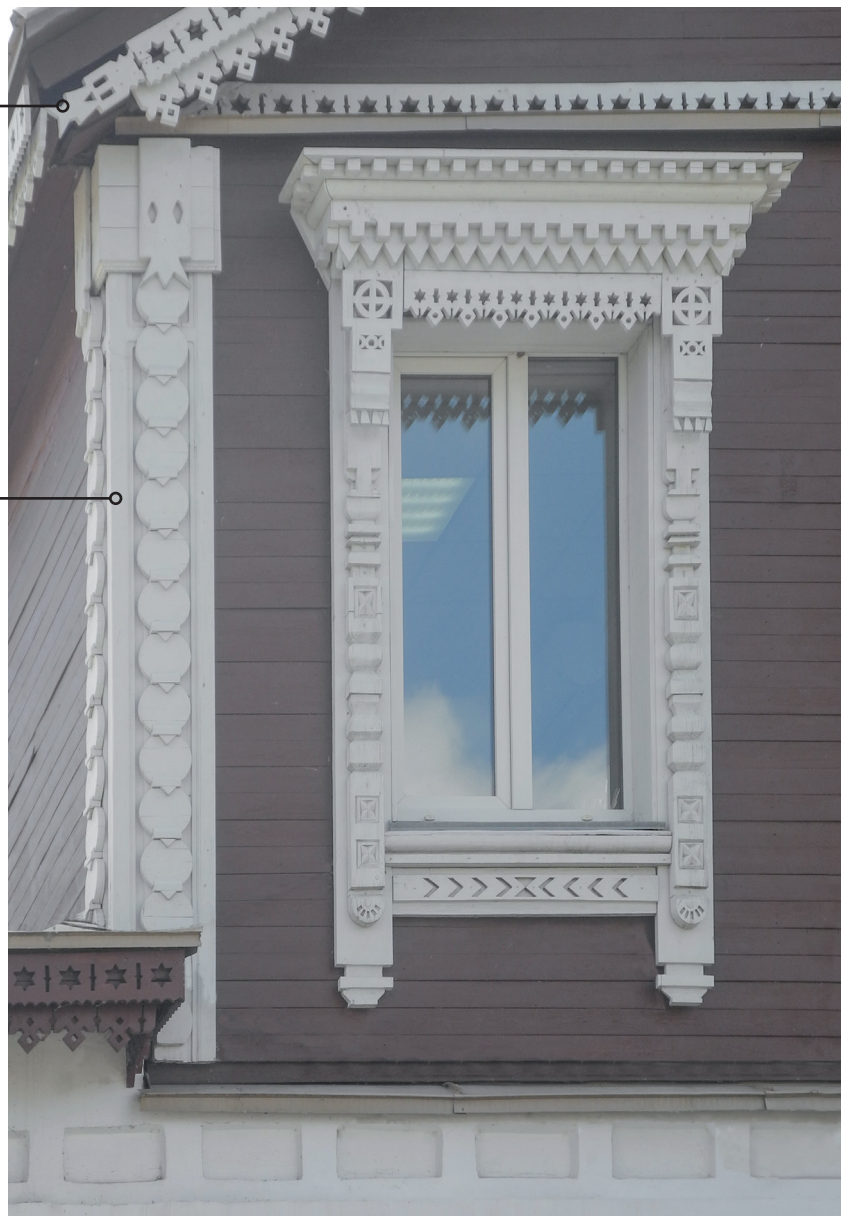
Фрагмент северного фасада
