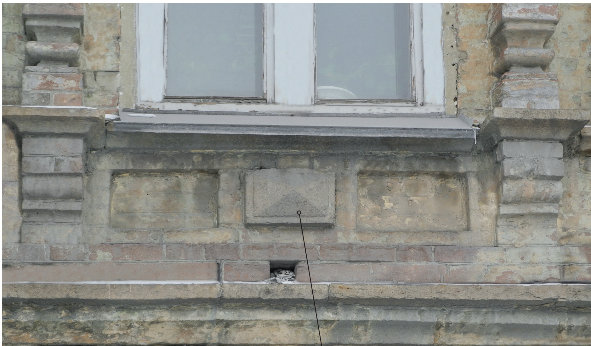
Обформление оконного проема
