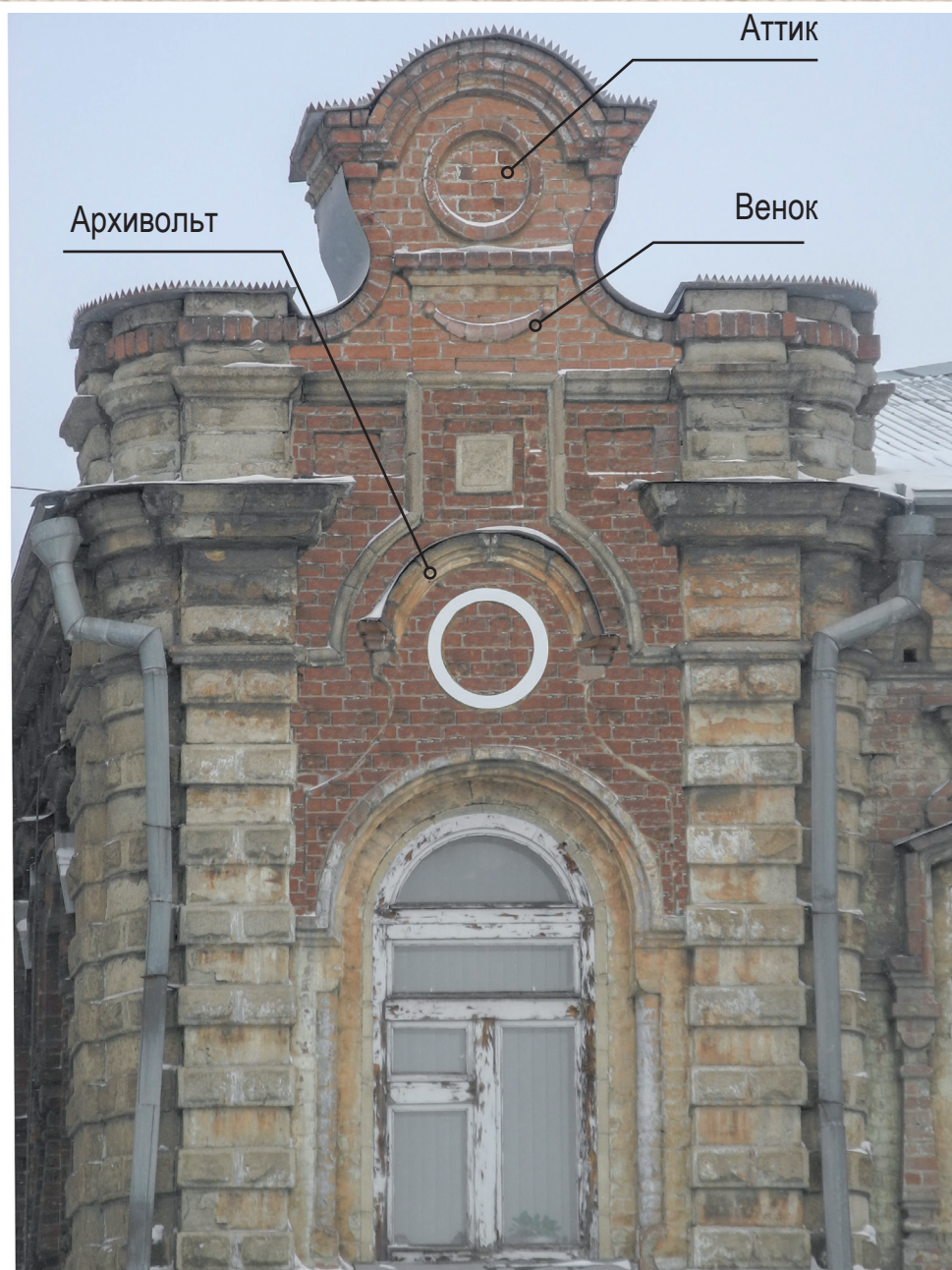
фрагмент южного фасада
