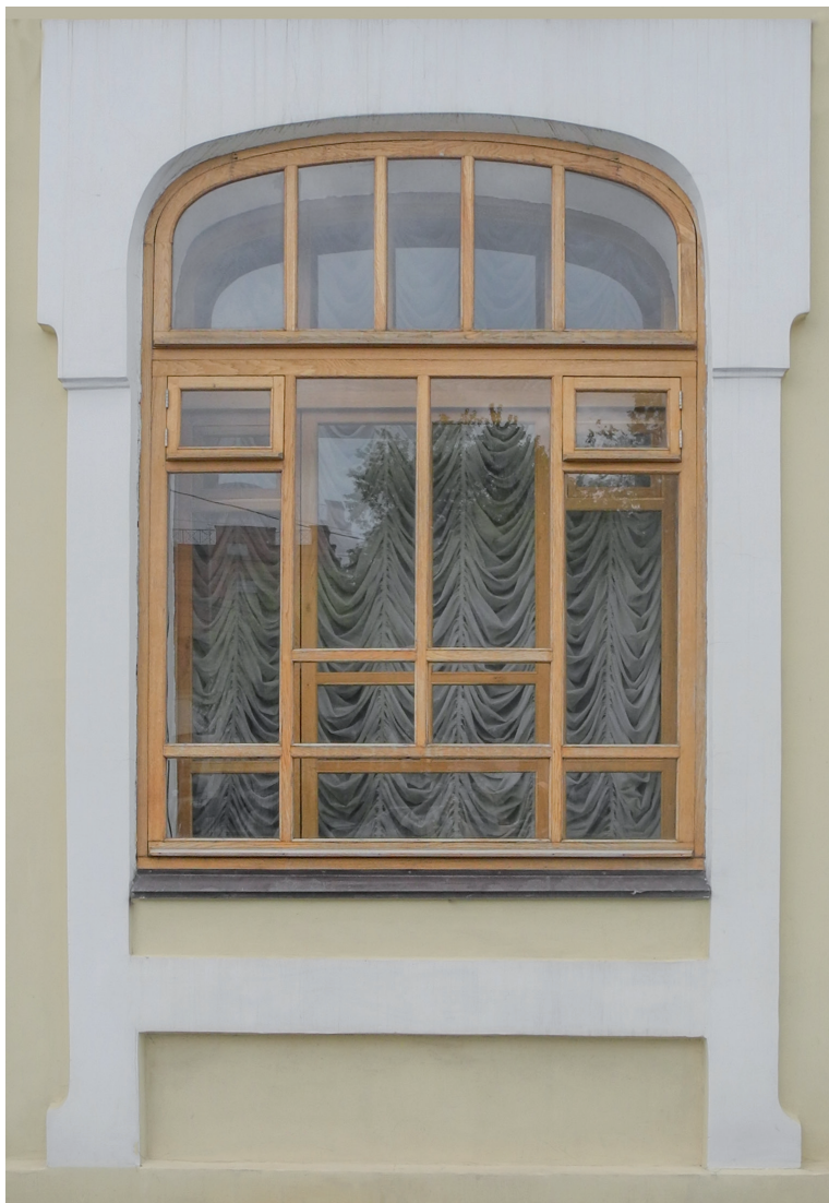
Обформление оконного проема
