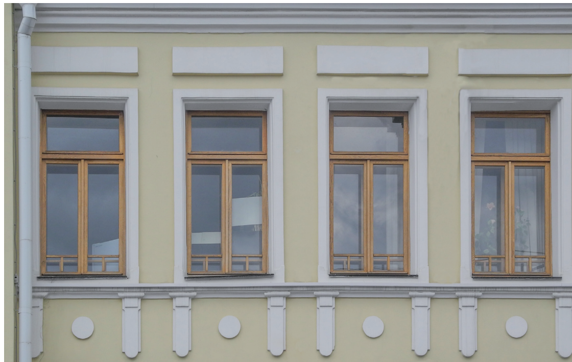
Обформление оконных проемов
