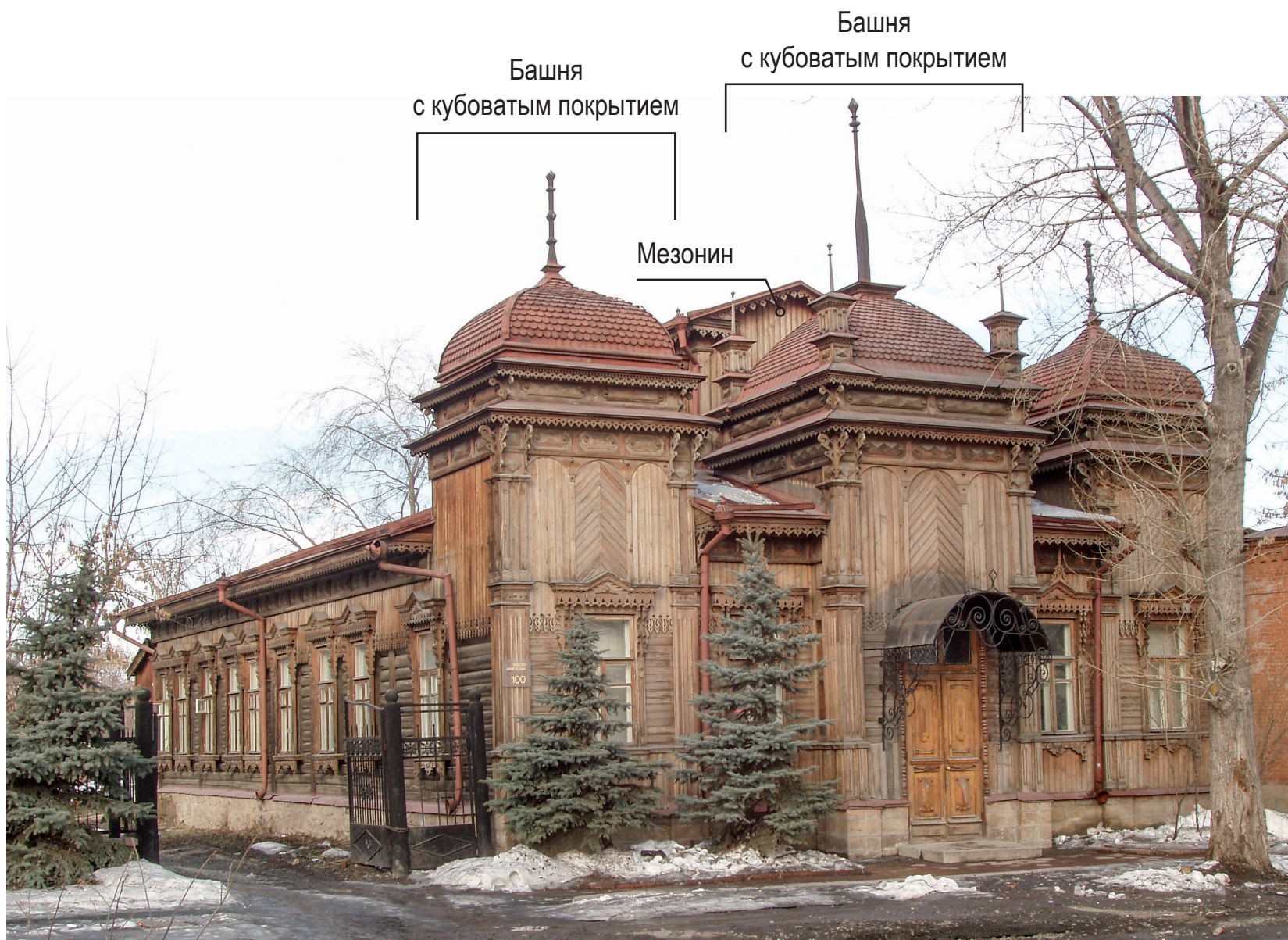
Южный и восточный фасады
