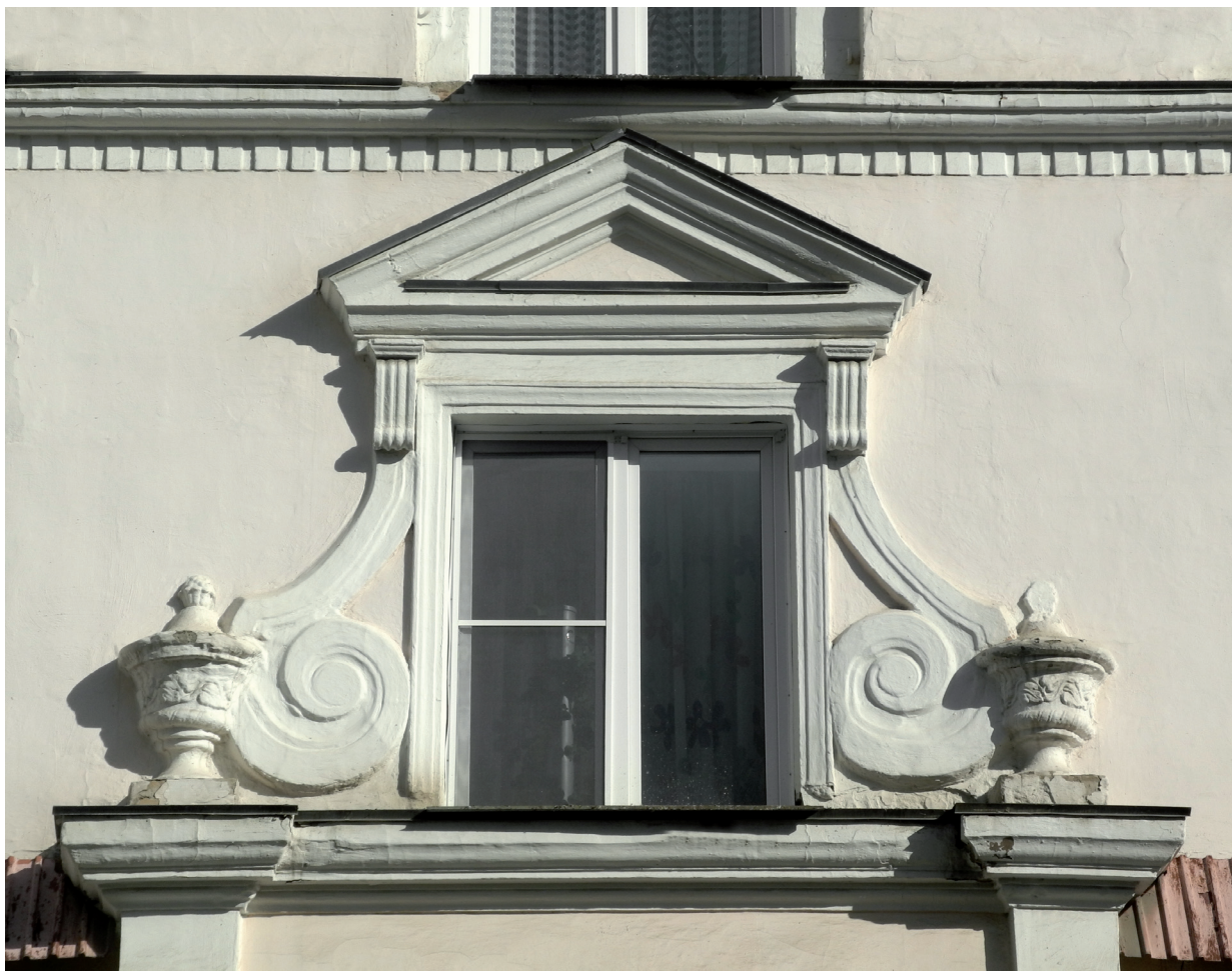
Оформление оконного проема
