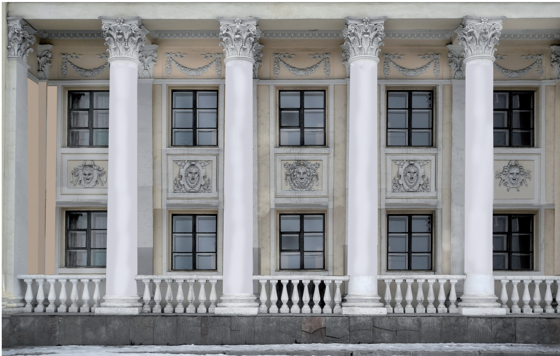
Фрагмент южного фасада
